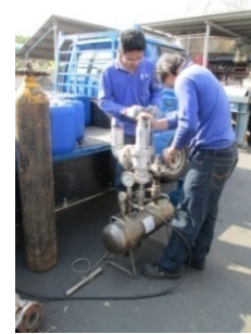
裝設壓力測試設備
